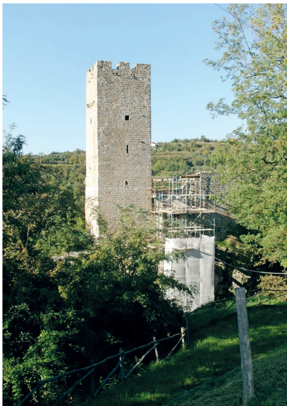
Il cantiere per la ricostruzione del portale (Ph. Franco Rota, 12.10.2025)
